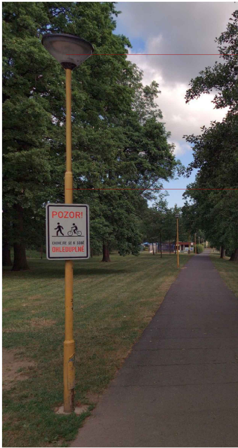
STÁVAJÍCÍ SVÍTIDLA PŘESAZENY NA NOVÉ SADOVÉ STOŽÁRY
